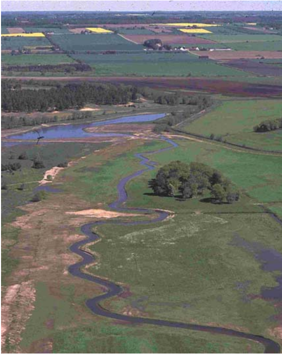
Figur 4. Klingavälsåns sträckning efter restaureringen – meandring och grundvattenhöjning. Den nya meandrande åslingan avslutas med en nyanlagd våtmark, vars uppgift är att förhindra sedimenttransport från den nygrävda åfåran vidare till nedströms liggande Kävlungeån. Till vänster i bilden syns spår av den gamla, raka åfåran som nu är igenfylld. Foto: Patrik Olofsson /N
