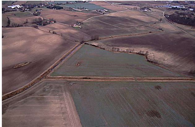
Foto mot NO med område 6 och 7 i övre delen av bilden. Svedala reningsverk uppe till höger.
